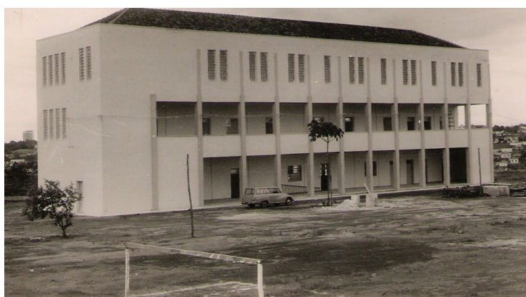
Foto 1 - Prédio na reforma e após (Museu), no Campus Santa Mônica, em 1964.
