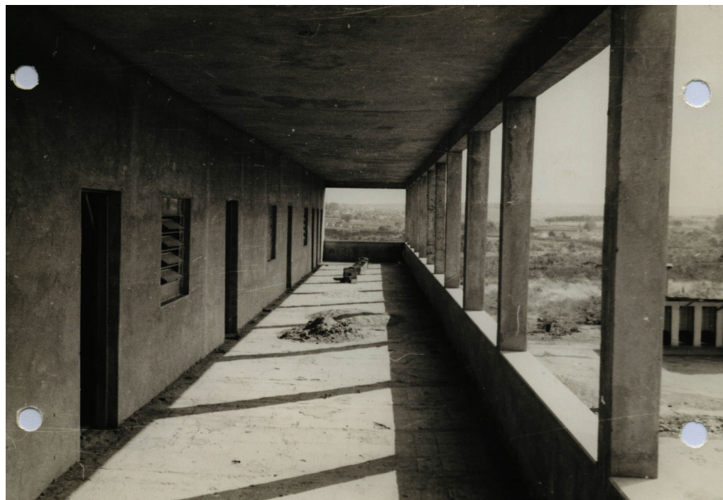
1964 - Acabamento do primeiro prédio (1Q)
