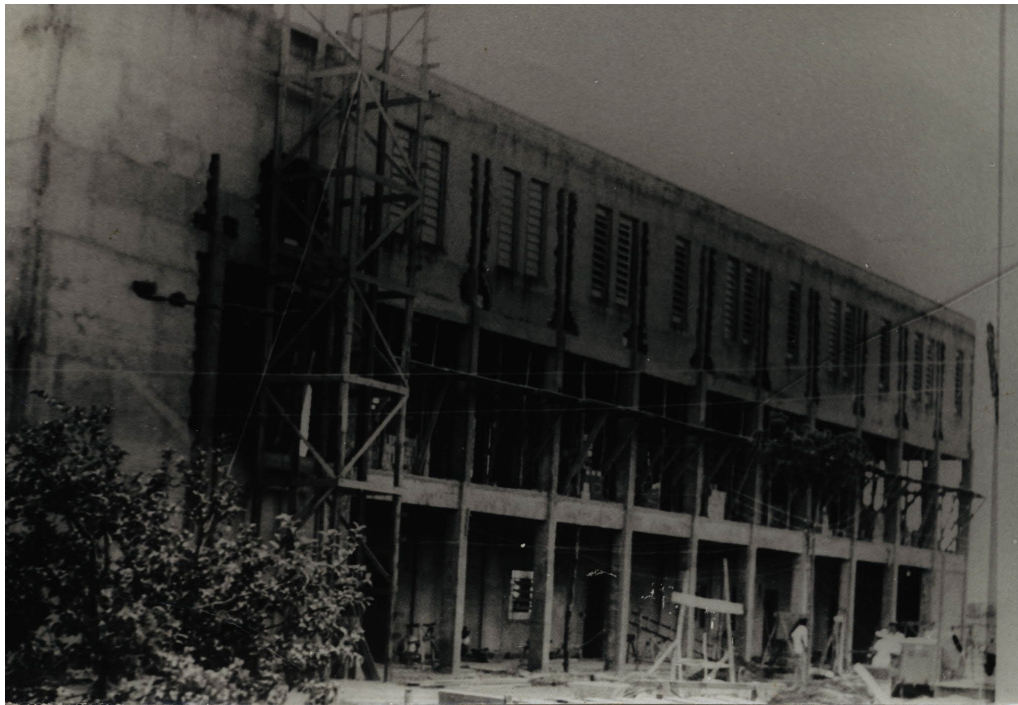
1964- O primeiro prédio (1Q) em obras
