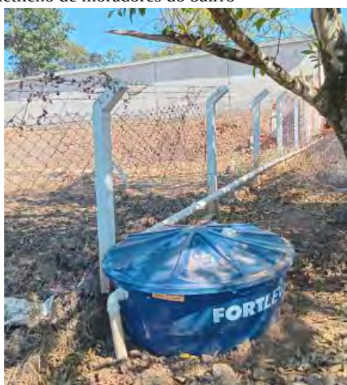
Figuras 3 e 4 – Fossa de pneus e polietileno de moradores do bairro
