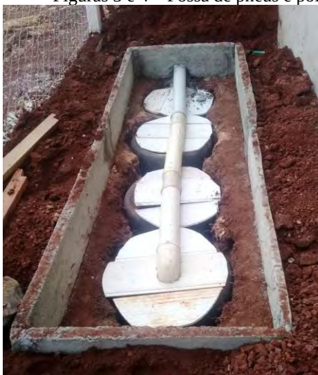
Figuras 3 e 4 – Fossa de pneus e polietileno de moradores do bairro
