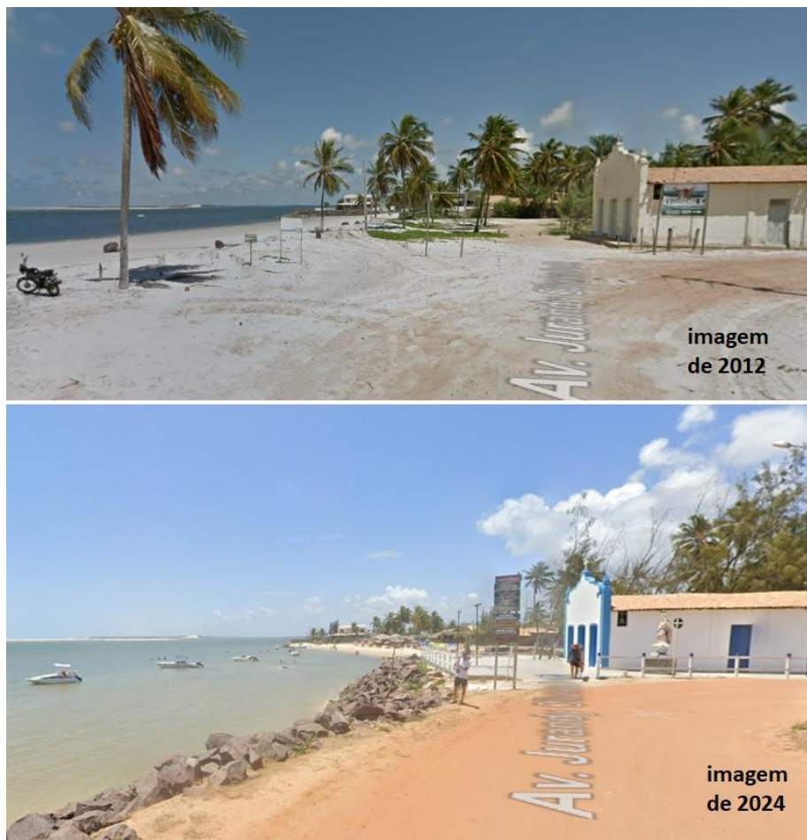
Figura 6 – Imediações da capela de Nossa Senhora da Boa Viagem. Destaque para a praia existente em 2012 e sua supressão por erosão costeira evidenciada na imagem de 2024. Outro destaque para a camada de enrocamento que protege o talude erodido.
